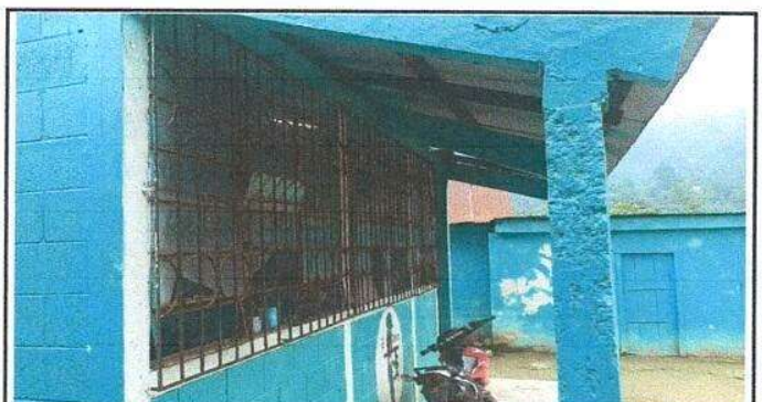
Foto 6: Sustitucion de balcones de metal.
