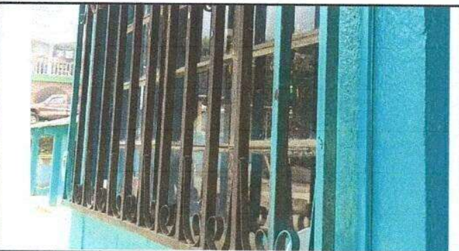
Foto 5: Mantenimiento a balcones de metal
