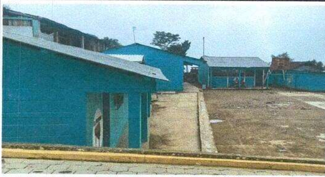
Foto 3: Pintura en muros exteriores e interiores
